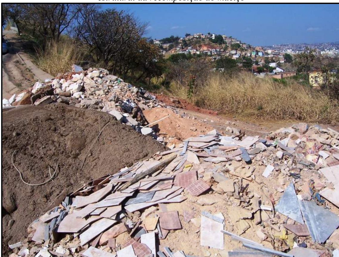
O entulho inerte de construção civil sendo disposto para o preenchimento da ravina
