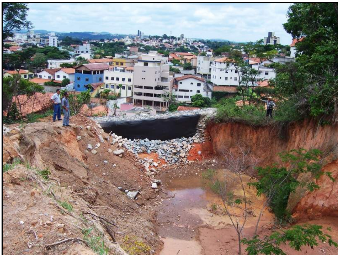
Detalhe da grande ravina e da implantação de estrutura permeável de contenção como elemento estrutural da recomposição do maciço
