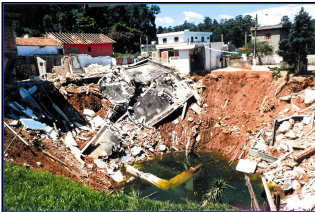
O famoso Buraco de Cajamar, colapso ocorrido em agosto de 1986 no bairro de Lavrinhas. (Foto arquivo IPT)
