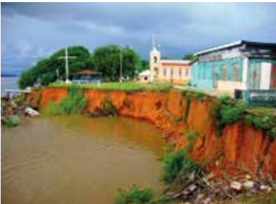
Terras caídas. Porto Velho – RO
