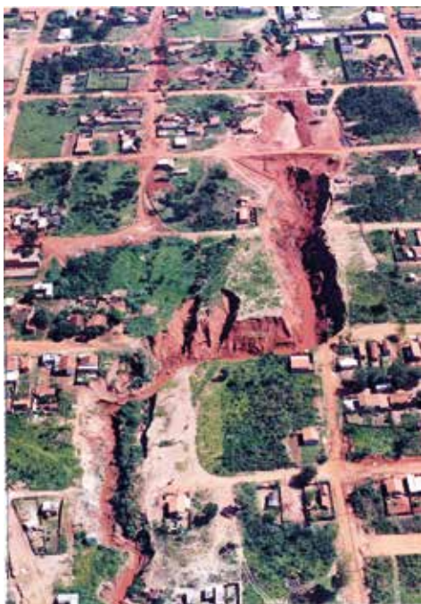
Suscetibilidade à erosão no oeste paulista. Foto: IPT
