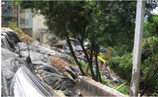
Idem. Deslizamentos em cabeceira de grota. Franco da Rocha – SP. Foto: ARSantos
