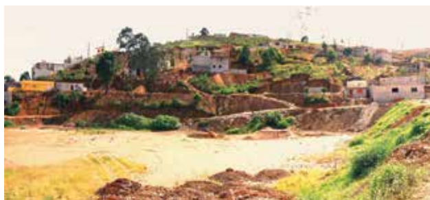
Ocupação irregular Vila Operária. Guarulhos – SP. Foto: ARSantos
