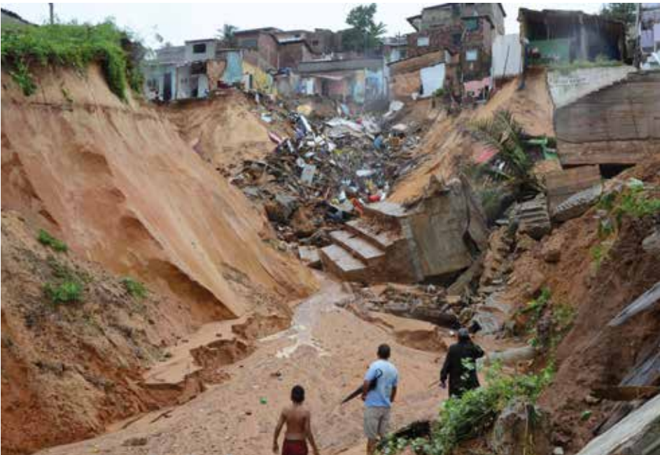
Processo erosivo associado a fortes chuvas, solos de alta erodibilidade e equívocos técnicos da drenagem urbana. Natal (RN). Foto: Léo Carioca
