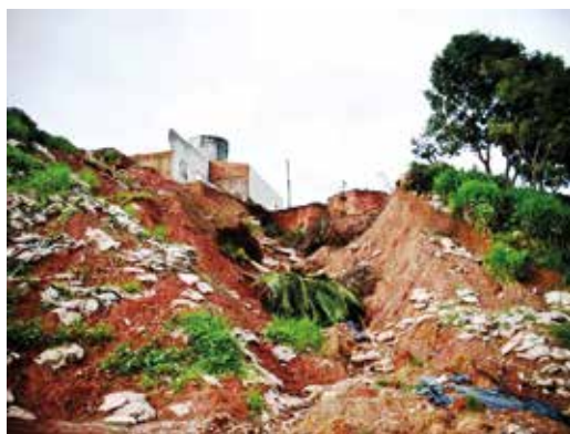
Processos erosivos remnantes decorrentes de falta de cuidados no lançamento de águas pluviais e esgotos urbanos
