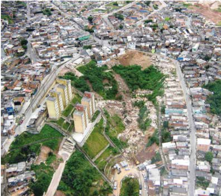
Ocupação indevida de cabeceiras de drenagem (grotas), feições geomorfologicamente críticas que devem ser consideradas áreas non aedificandi . Santo André – SP. Foto: ARSantos
